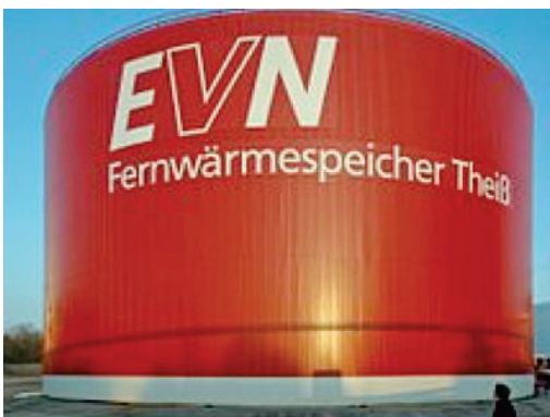
Serbatoio di accumulo termico per riscaldamento di distretto in Austria con capacità termica di 2 GWh
